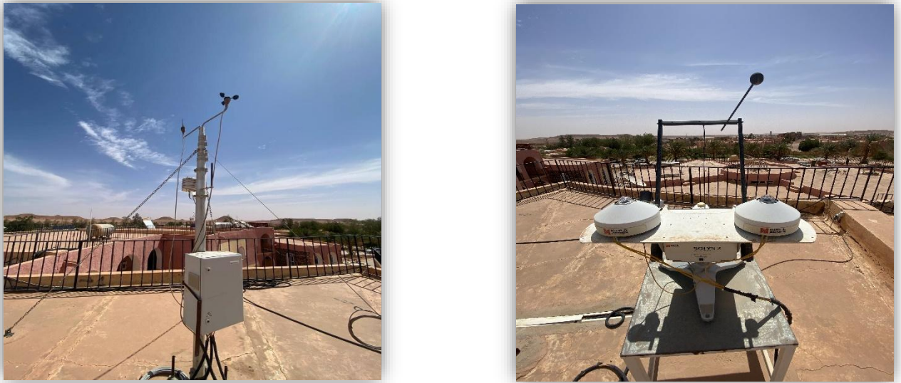
Figure III. 9. Photo de l'équipement de mesure du rayonnement, de la température et de l'humidité relative de l'air entourant l'unité d'énergies renouvelables (URAER).
