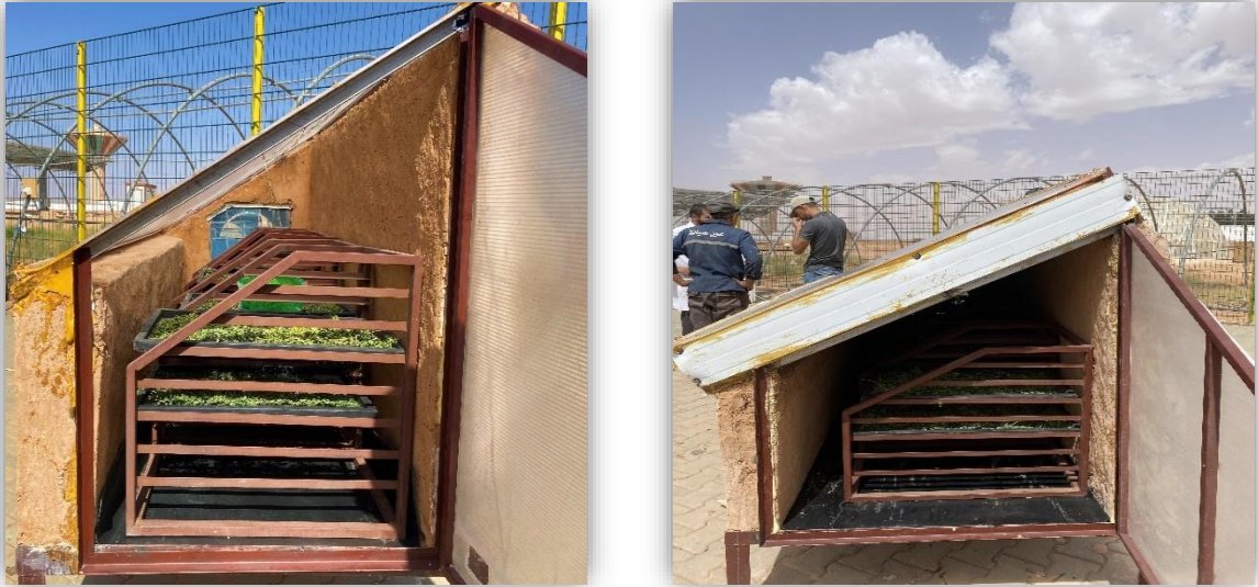
Figure III. 5. Photographie de la chambre de séchage, (Gauche) séchoir solaire direct ; (Droit) séchoir solaire indirect.
