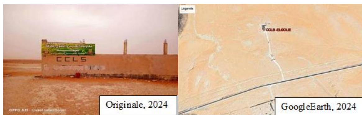
Figure 05 : Aperçu sur la station CCLS El-Menia (Google.Earth)
