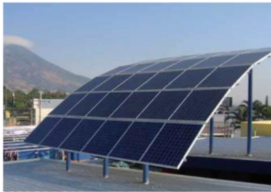
Figure I. 4. Nettoyer les abords des Panneaux solaires [3]
