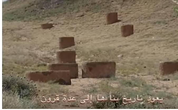
الشكل 04: آبار تحفظ قنوات نقل الماء من الانفجار
