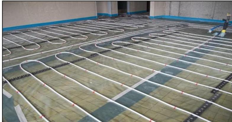
**Figure I.5.** Plancher chauffant (Le chauffage au sol)
