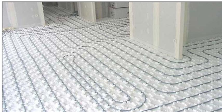
Figure I.8. Réseau de tubes d'un plancher chauffant hydraulique.
