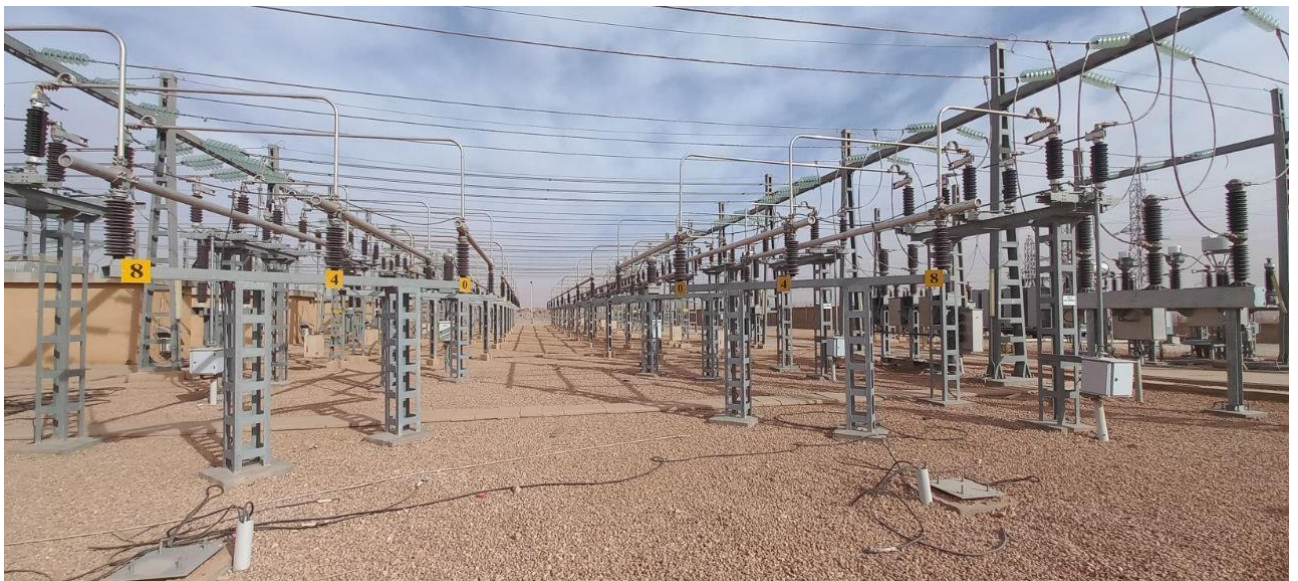
Figure II.11 : Photo de jeux de barres.
