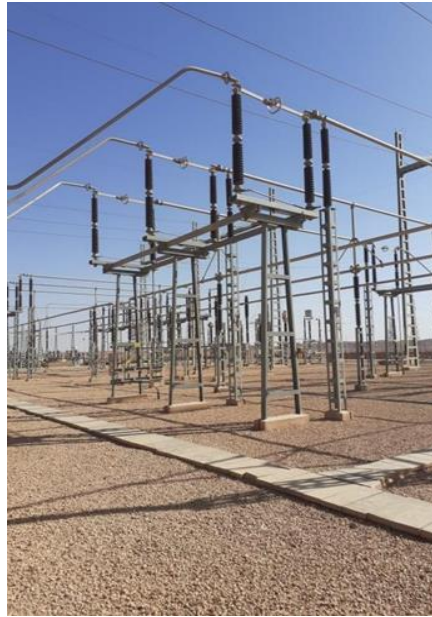
Figure II.10 : sectionnaire de barre (de sectionnement ou d'aiguillage).
