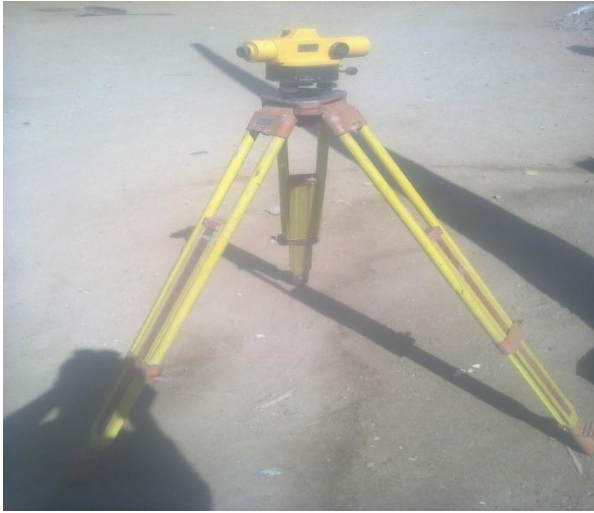
Figure 4.2 Nivellement de la tranchée et pose du lit de sable.
