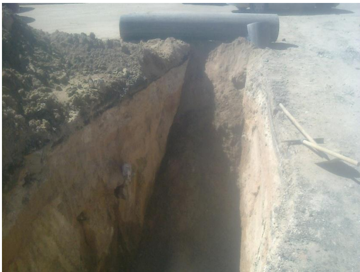
Figure 4.1Le terrassement par engin mécanique.
