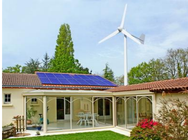
Figure II.28 : l'ensemble (éolienne + panneaux solaires) pour l'alimentation électrique
