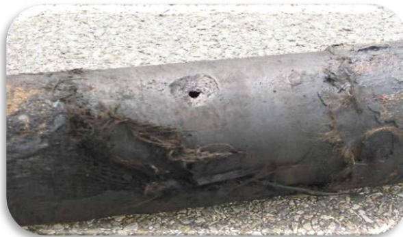
Figure N°10: Corrosion caverneuse d'un acier allié sous un joint [28].
