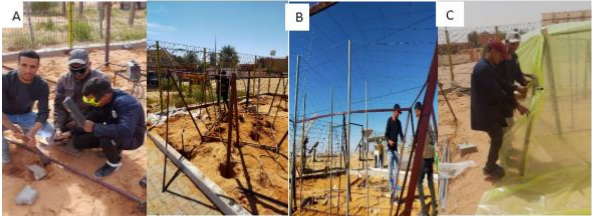
Figure III. 6: (A) Soudure au poteau, (B) Serrage des câbles et (C) Couverture
