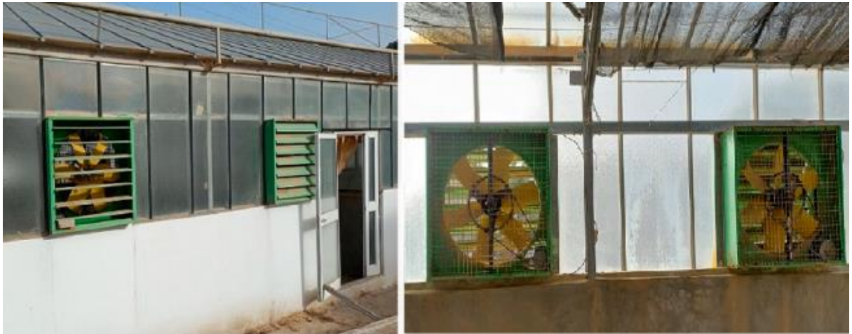
Figure I- 6: Une serre équipée de dispositifs de ventilation forcée à des Régions Arides (Kébili, Tunisie).
