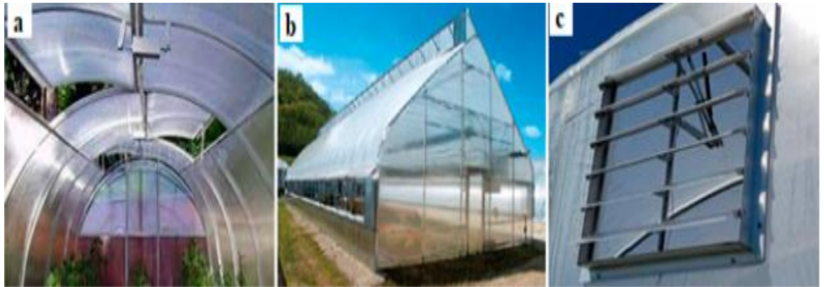
Figure I- 5: Différents types d'ouvertures de serre : (a) événements de toit ; (b) événements de faîte ; (c) événements latéraux.
