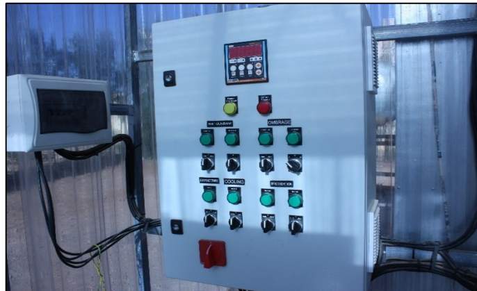
Figure 38 : Régulateur automatisé la serre de Ghardaïa (Original).
