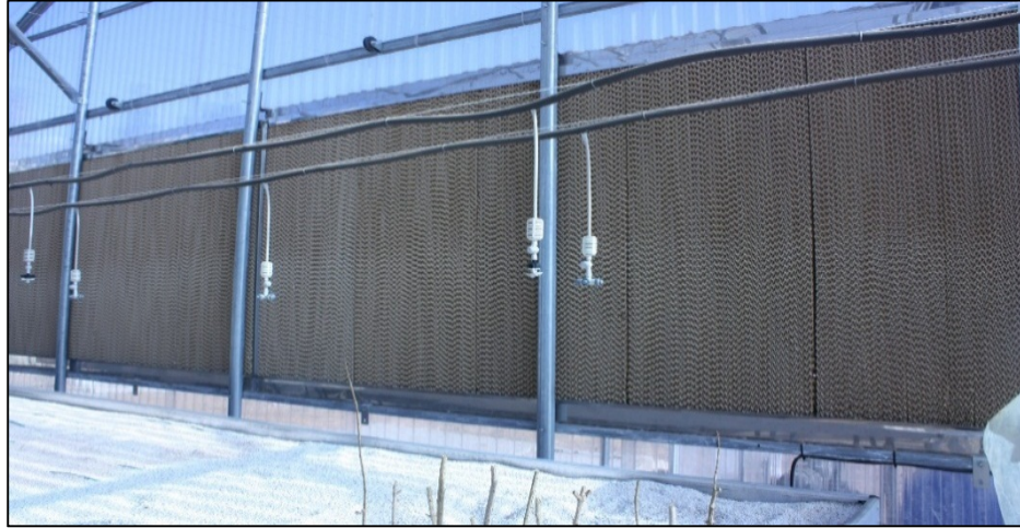
Figure 37 : Système de refroidissement par Cooling (Original).
