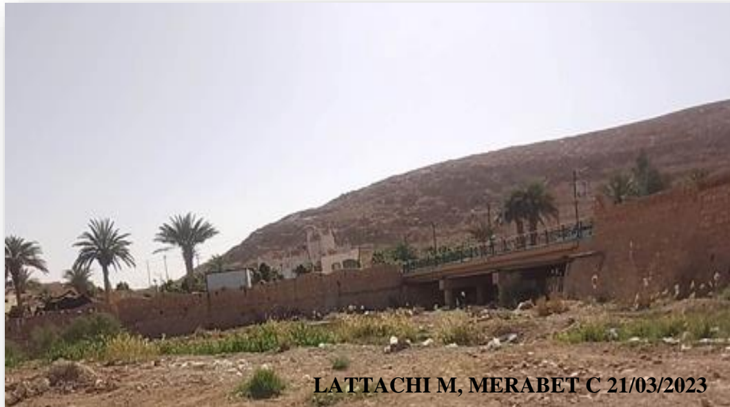
photo 2 : Aperçu sur la station 02
