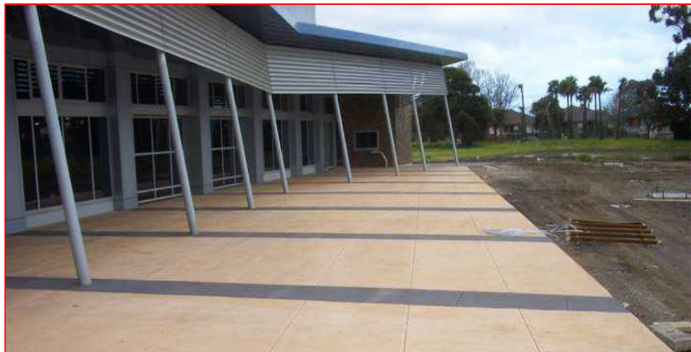
Figure I.5. Pavé de géopolymère en Australie [17].
