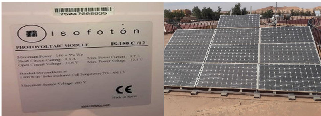
Figure IV.3: Caractéristiques du module (PV) IS-150 C/12.
