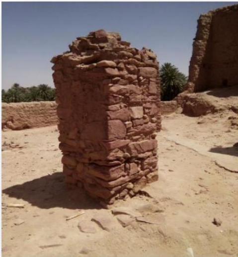
الشكل 1. 14 طريقة بناء الأعمدة الحجرية. المصدر: محبوب، 2017
