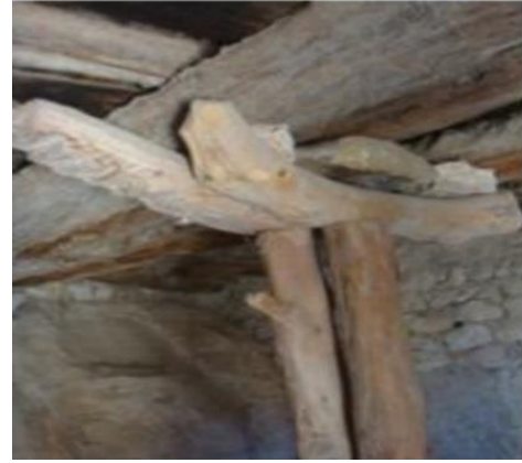
الشكل 1. 13 طريقة بناء الأعمدة الخشبية. المصدر: حجازي 2017
