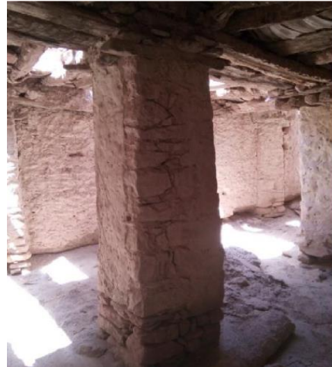
الشكل 1. 14 طريقة بناء الأعمدة الحجرية. المصدر: محبوب، 2017
