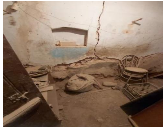
الشكل 9.2: توضح ظهور تشققات الرأسية في الجدار. المصدر: الكاتب
