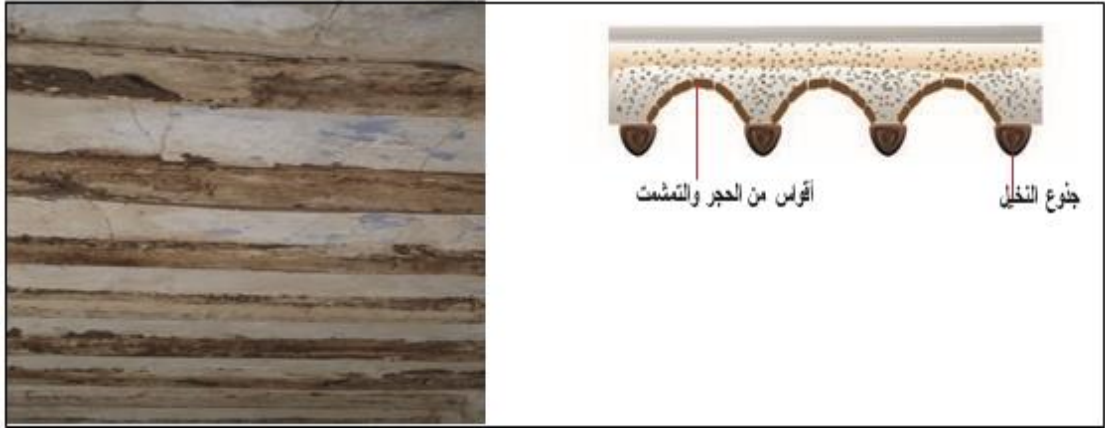
الشكل 11.1 الأسقف بالقباب في المباني الطينية. المصدر: بن سالم، بلحاج
