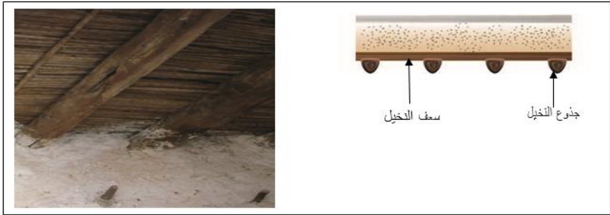
الشكل 10.1 الأسقف المسطحة في المباني الطينية. المصدر: بن سالم، بلحاج
