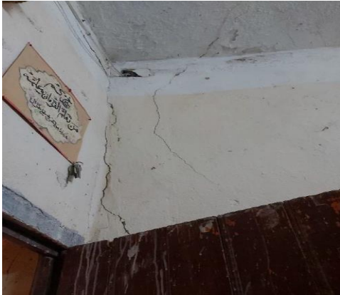
الشكل 9.2: توضح ظهور تشققات الرأسية في الجدار. المصدر: الكاتب
