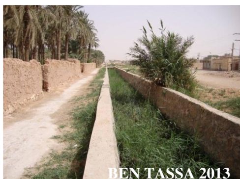
Photos 05 : Système de drainage
