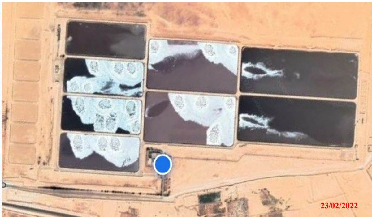
Photo 1. Vue aérienne de la station d'épuration de Ouargla (STEP de Ouargla ,2022).
