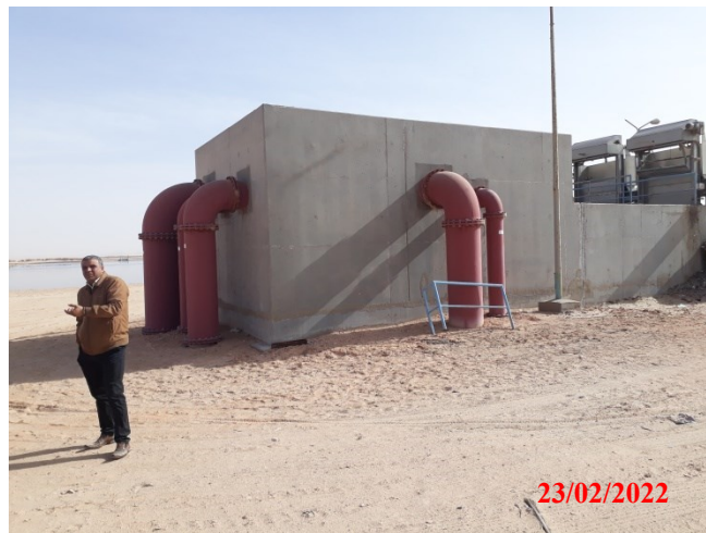
Photo 2. Entrées des eaux usées à l'ouvrage de prétraitement de la station d'épuration (STEP de Ouargla ,2022).
