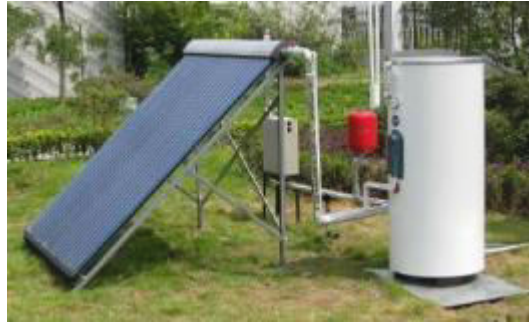
Figure II.19: chauffe-eau thermosiphon à éléments séparés [11].
