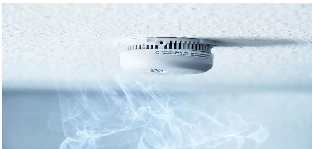
Figure 1. 3:détecteur de fumée
