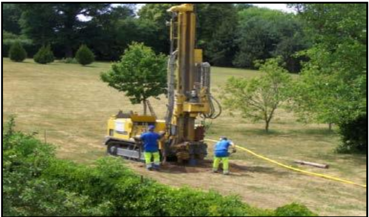
photo ( IV .02): Machine De Forage Piézométrique
