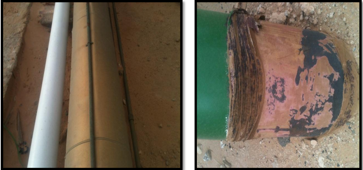
Figure N° IV.4 : Protection par revêtement métallique et organique.
