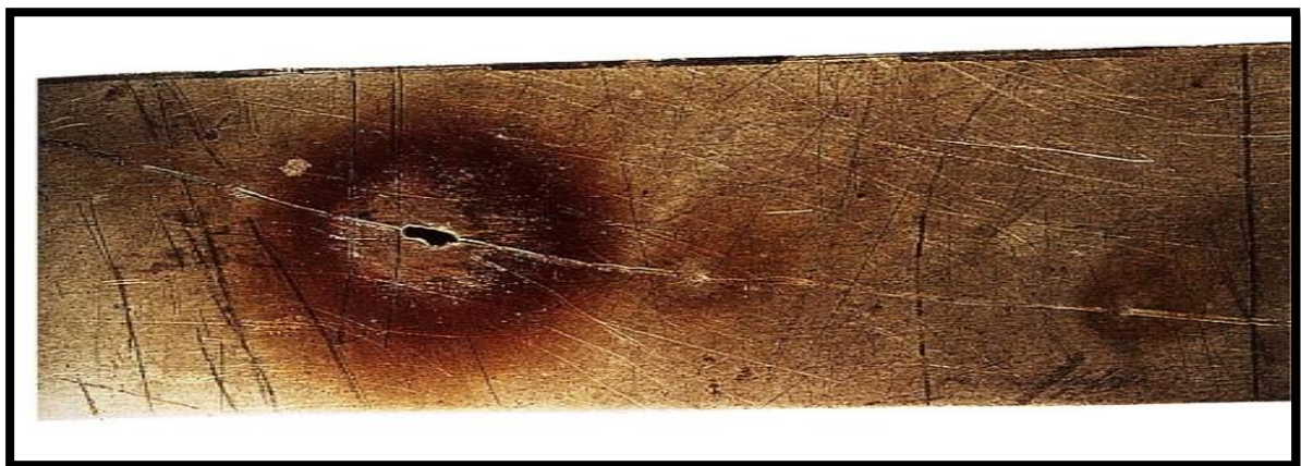
Figure N° II.2 : Corrosion par piqûres sur la paroi d'une cuve en acier inoxydable austénitique Cr18-Ni10.
