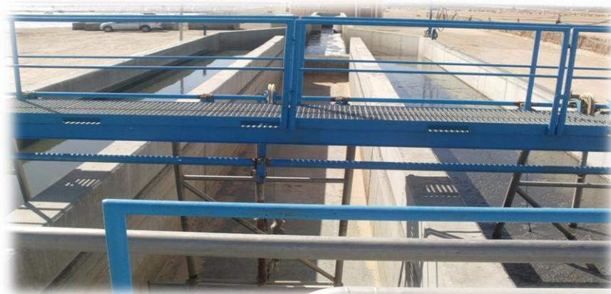
**Figure (13) :** Ouvrage de dessablage et déshuilage combinés
