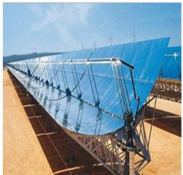
**Figure I.9:** Centrale constituée de capteurs cylindro paraboliques
