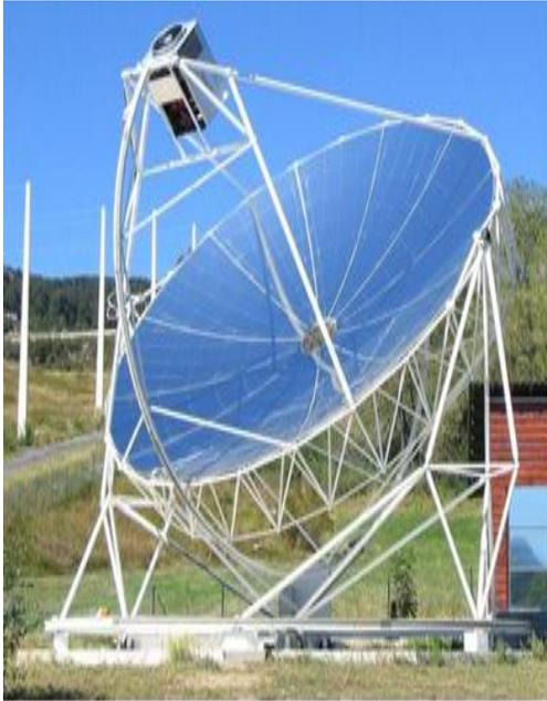
**Figure I.10:** Centrale solaire parabolique
