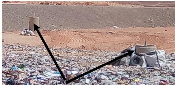
**Images N° 11 : Tube de sortie biogaz.**
