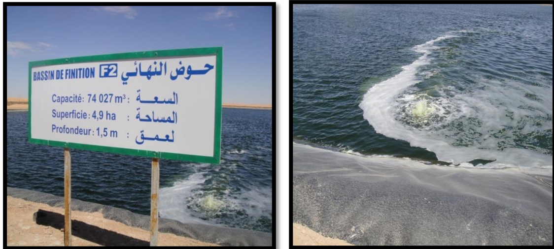
Figure 3.7 La lagune de finition
