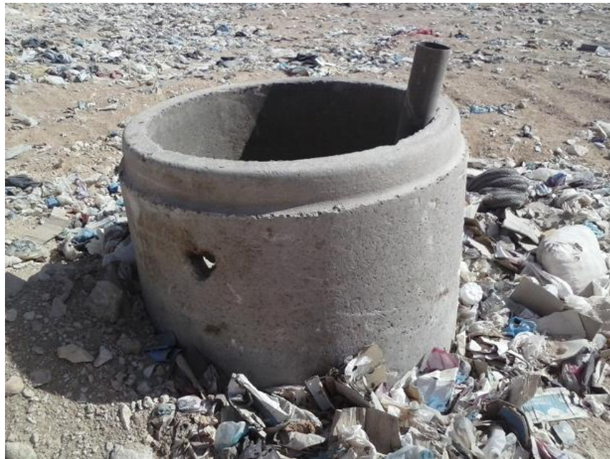
Photo 12 : Buse en béton perforée (CET- v. M'Zab).
