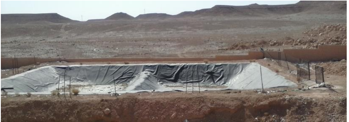
Photo 11 : Bassin de Lixiviat (CET- v. M'Zab).
