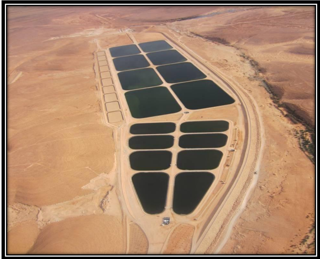
Figure III.2 : Vue aérienne de la STEP d'EL-ATTEUF
