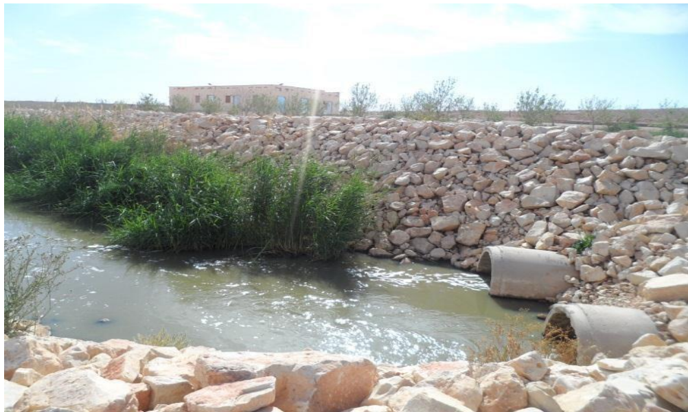
Photo III.4 : L'exutoire de la STEP KafEddoukhane
