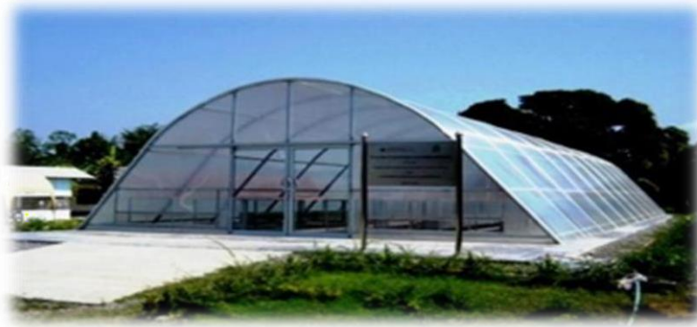
Fig. II 8. Séchoir de type serre à grande échelle avec brûleur GPL [Janjai et al, 2011]
