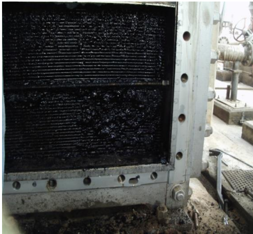
Figure II-8 : L'état d'échangeur a plaque
