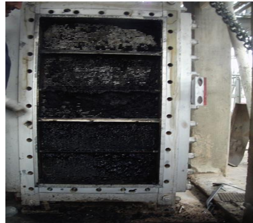
Figure II-8 : L'état d'échangeur a plaque
