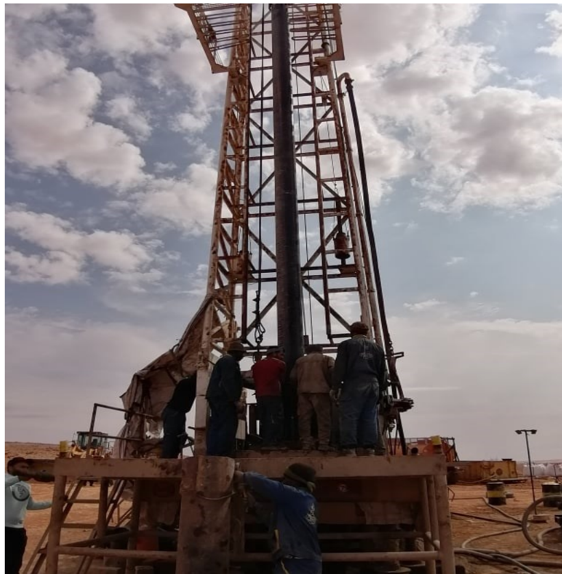
Figure III.11 : Mise en place du tubage.
