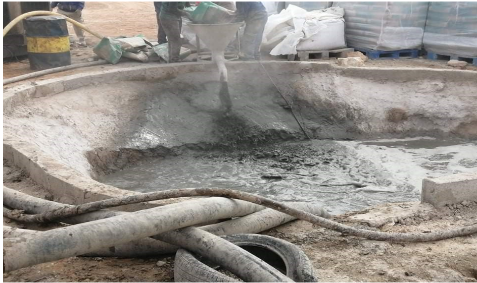
Figure II.16 : malaxage du laitier de ciment.
