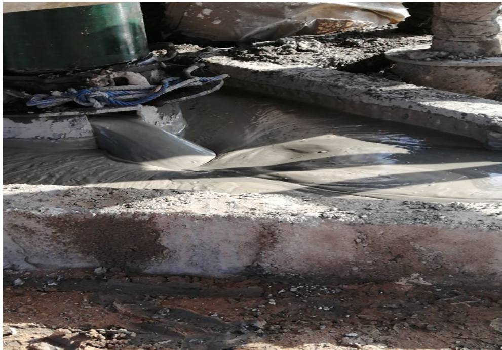
Figure III.13 : chasse le ciment par l'injection de boue
