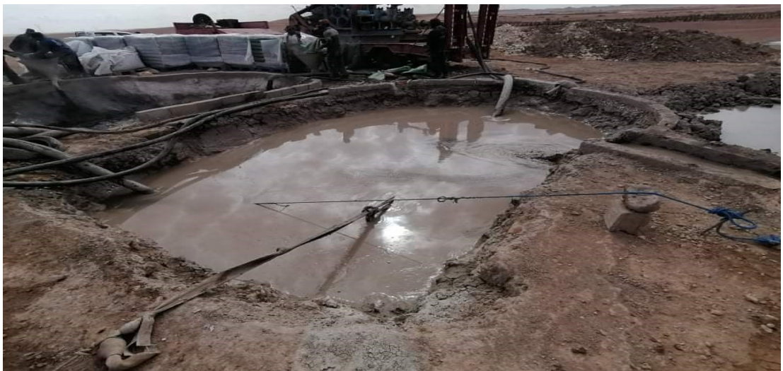
Figure III.3 : bassins à boue de bentonite.
