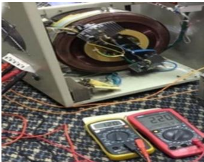
Figure1.7. Vérifier les stabilisateurs de tension avec un voltmètre.
