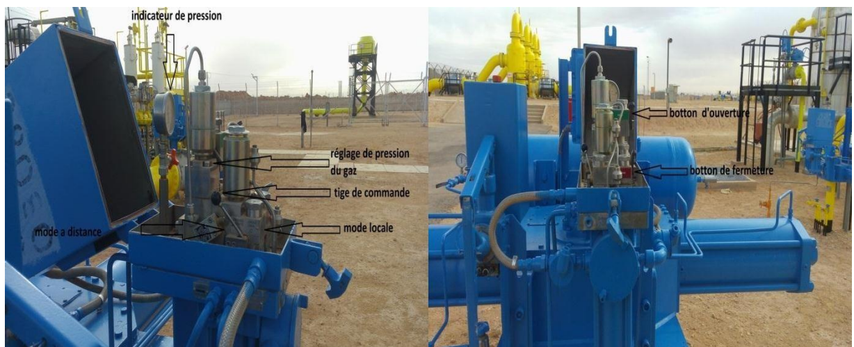
Figure. III. 4. Description de la boîte de commande
