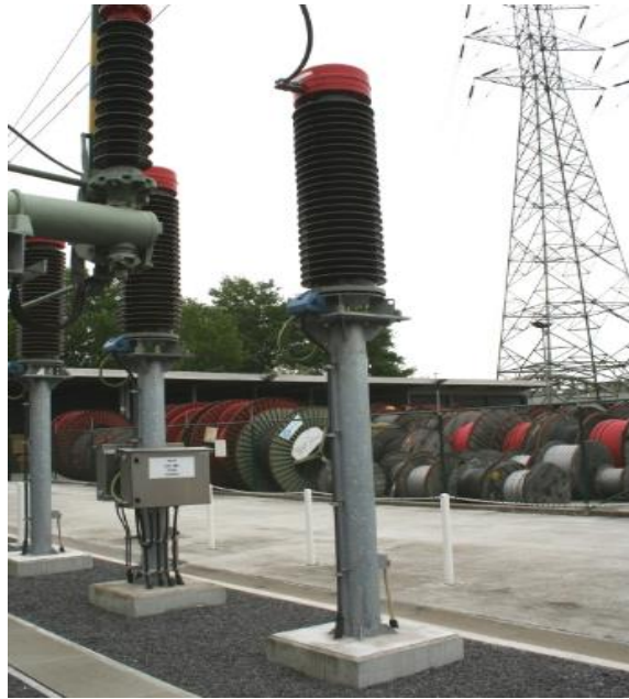
Figure III. 7 Transformateur de tension (TT) [12]
