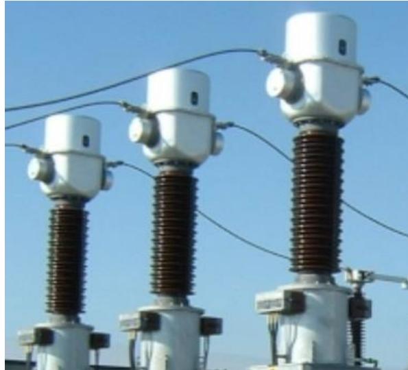
Figure III. 6 Transformateur de courant (TC) [12]
