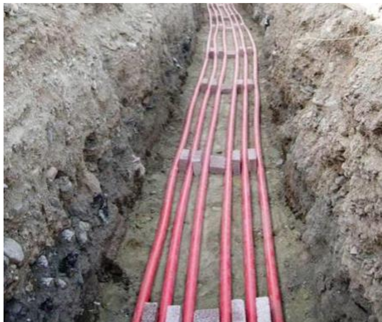
Figure I.3 Réseaux HTA souterrains [6].
