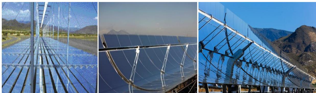
Figure 2.11 : Capteur à concentration
