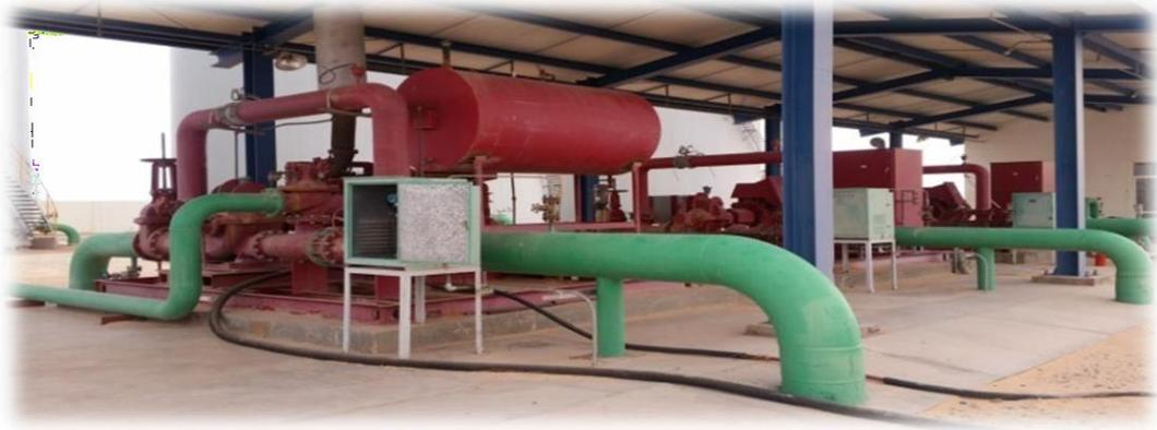
Figure II.03 : Les électropompes
