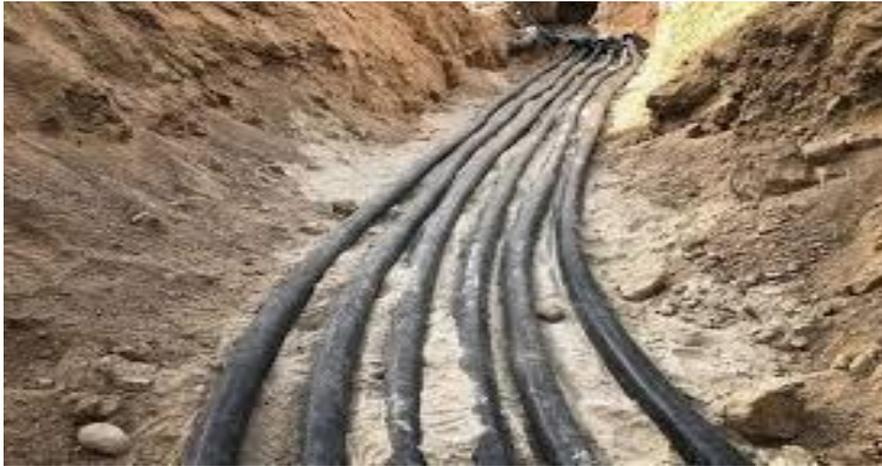
Figure 1-8 Le réseau MT souterrain.
