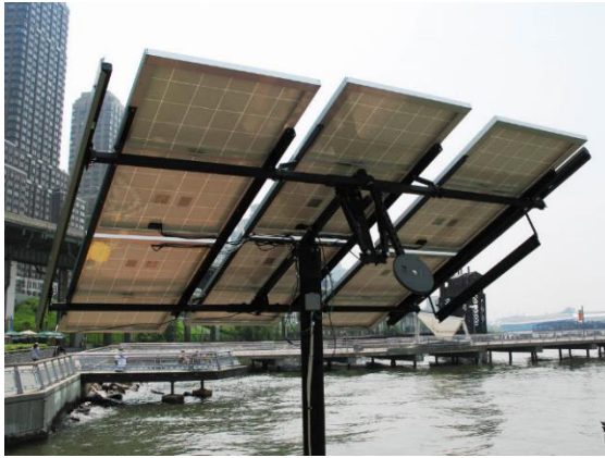
Figure 1.15 : Modèle d'un système de poursuite solaire à double axes
