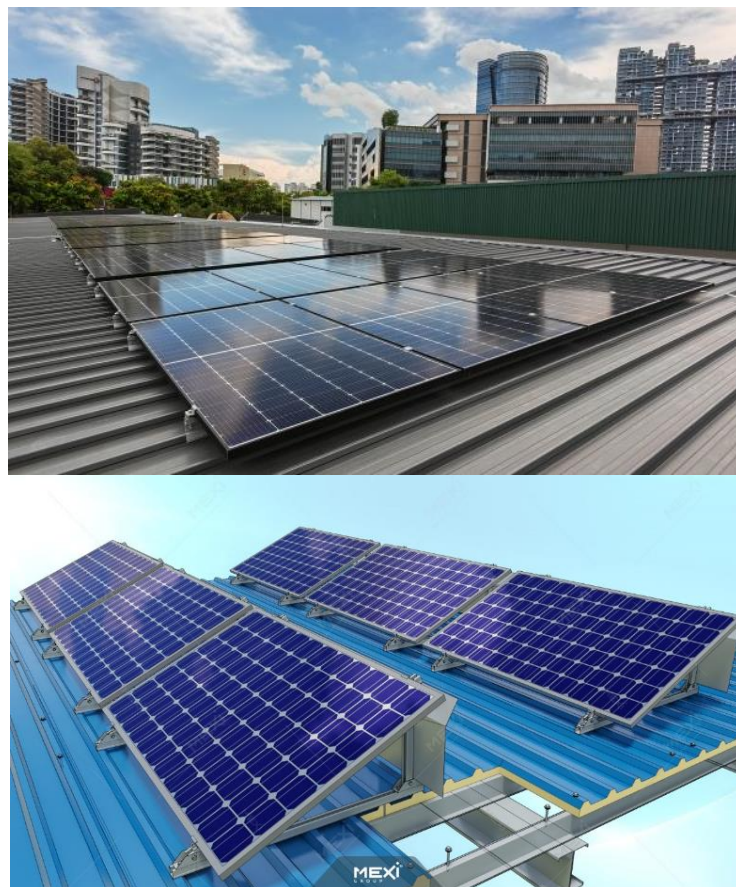
Figure 1.12 : Système de montage en toiture
