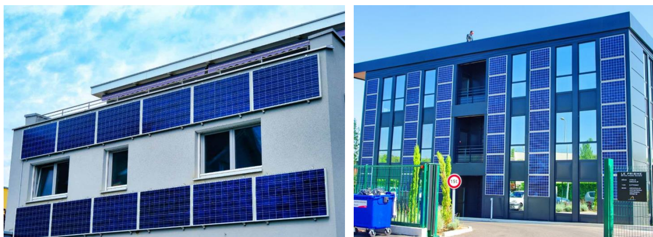
Figure 3.1 : Pose d'un générateur photovoltaïque en façade [52, 53]
