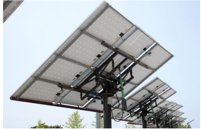
Figure 1.15 : Modèle d'un système de poursuite solaire à double axes
