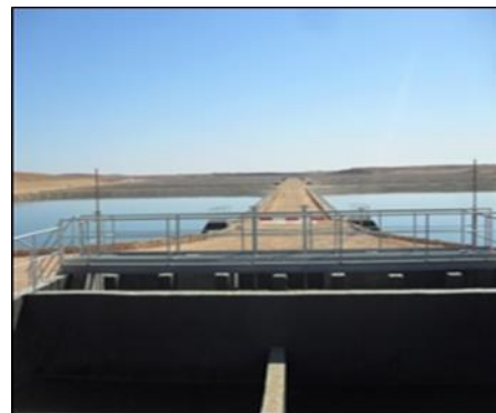
Figure I.7 : Répartiteurs vers les bassins primaires et secondaires [23]
