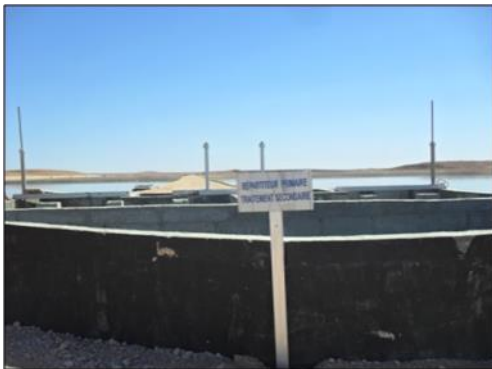
Figure I.7 : Répartiteurs vers les bassins primaires et secondaires [23]
