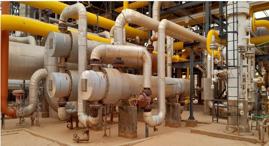
**Photo (III.1) :** Echangeur de chaleur à tubes et calandre dans l'unité GPL-2,CIS « Original »
