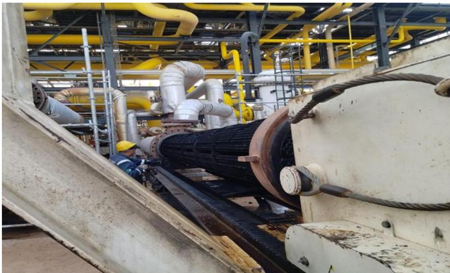
**Photo (III.2) :** Echangeur à tubes et calandre en état d'arrêt à l'unité GPL-2 « **Original** »
