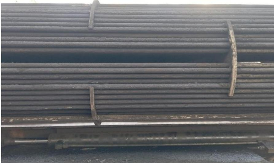
**Photo (III.3) :** Echangeur à tubes et calandre avec dépôt de coke à l'unité GPL-2
