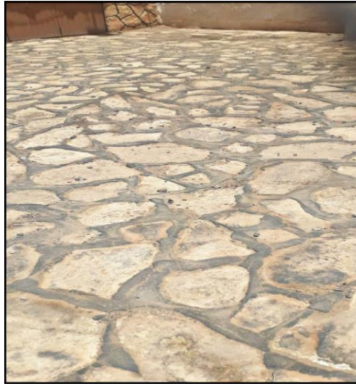
Figure 24 : Pavage des routes en pierre, [Les auteurs]
