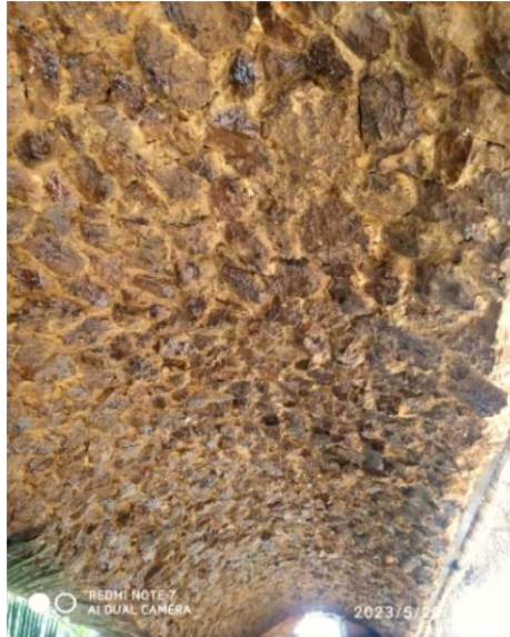
Figure 22 : toiture en pierre, [Les auteurs]
