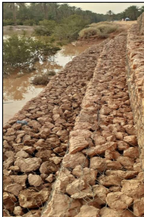
Figure 23: mur de soutènement, [Les auteurs]
