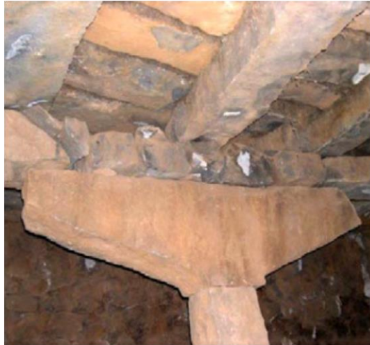
Figure 21: Plafonds d'arcs et de voutains en pierre (3)
