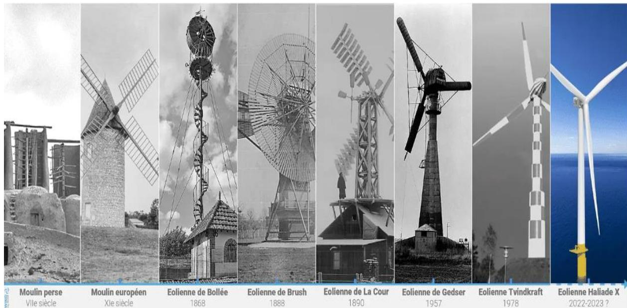
Figure (I.3) : Types et stades de développement des éoliennes [6]
