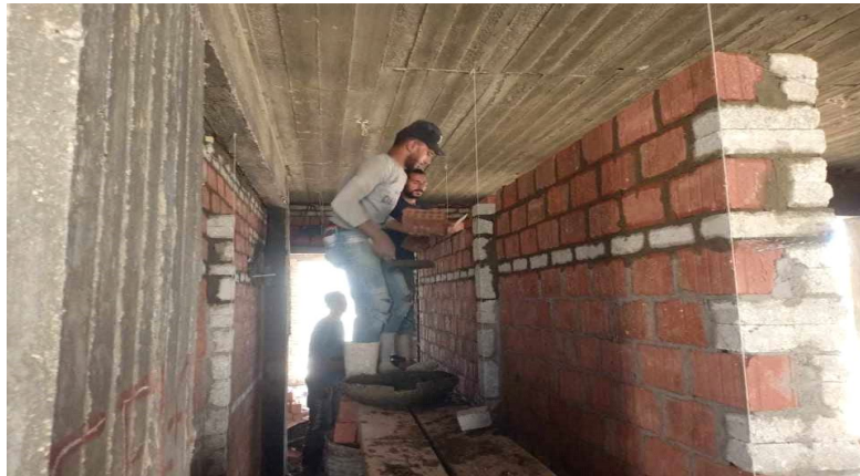
Figure I.5: Les joints de maçonnerie [6].
