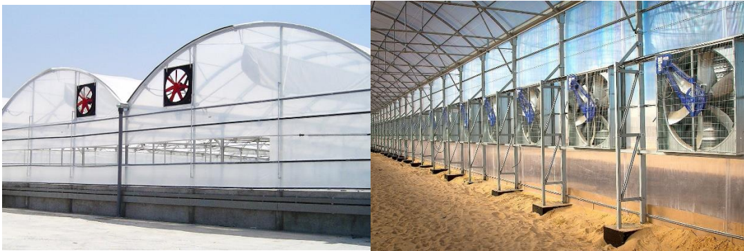
Fig 4: Une serre équipée de dispositifs de ventilation forcée [11].
