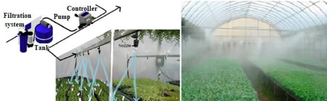
Fig.7 : refroidissement par un système de brumisation [27]
