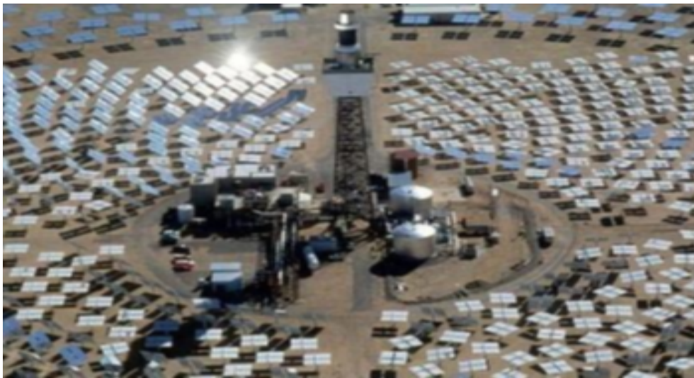
FIGURE 4.7 – Système de centrale à tour
