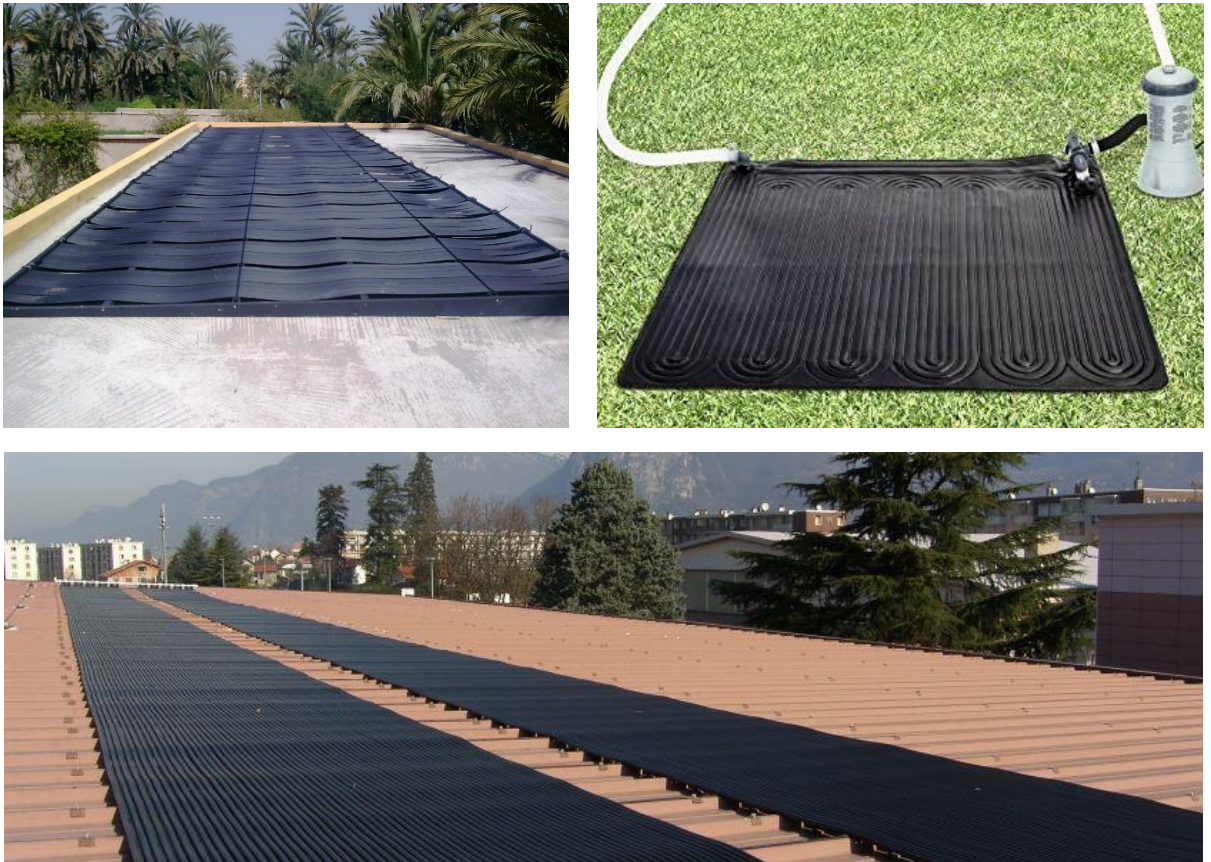
Figure 1. 7 : Implantation d'un capteur solaire de type moquette [8]
