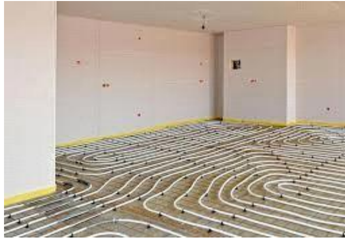
Figure 19 Réseau de tubes d'un plancher chauffant hydraulique[12]
