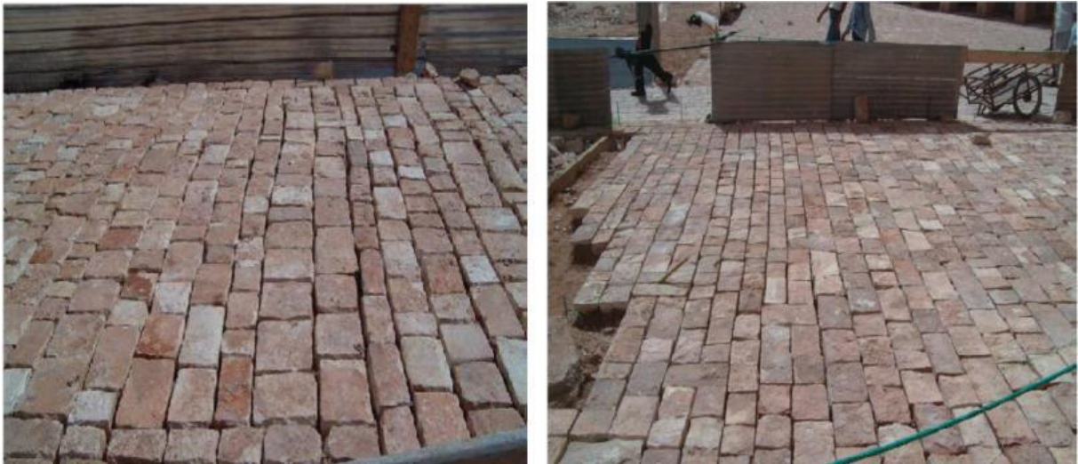
Photo 3.6 : L'appareillage de type droit. Source : [4]
