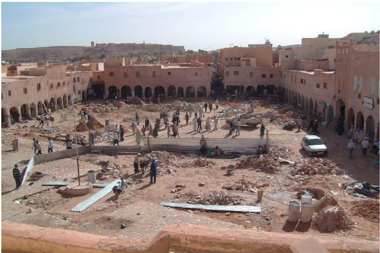
Photo 3.17 : Travaux de pavé. Source : [4]
