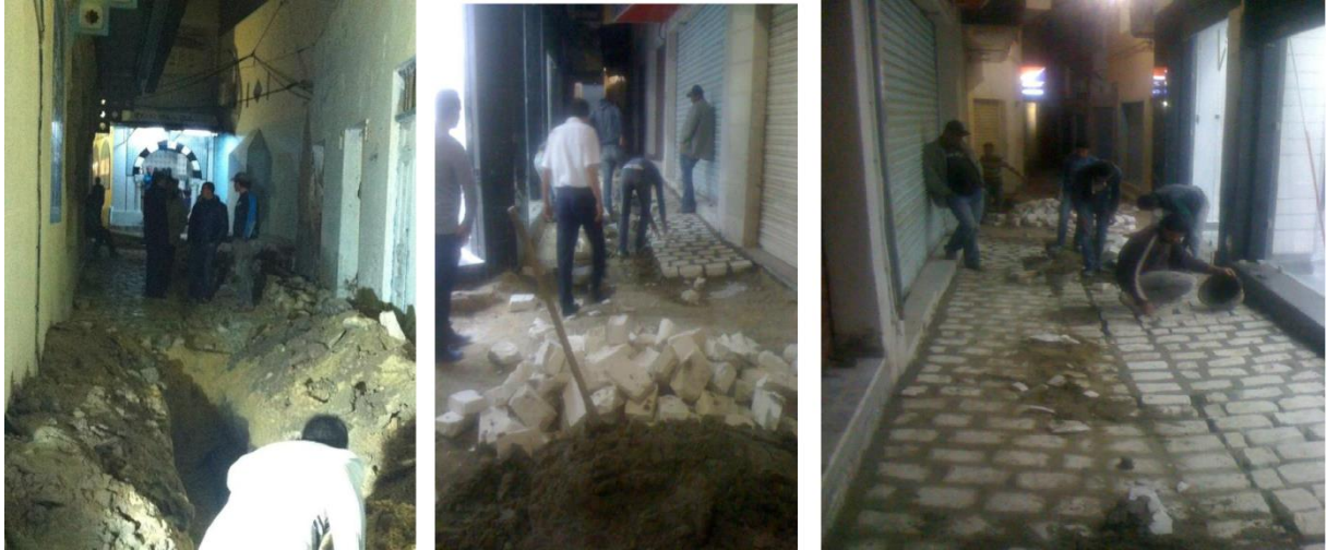
Photo 1.6 : Les travaux de réhabilitation en cours sur chantier, Source : [13]
