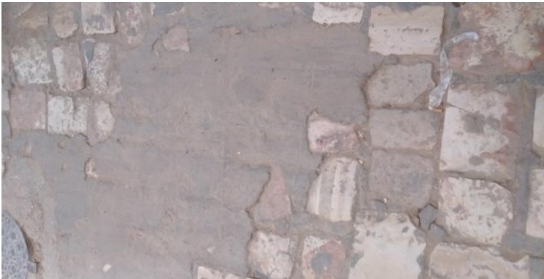
Photo 5.18 : Des pavés de mauvaise qualité. Source : Auteurs
