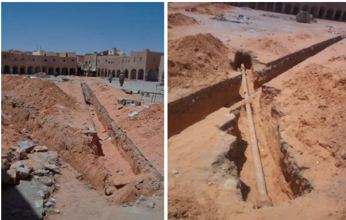
Photo 2.10 : Travaux de réseau d'assainissement. Source : [4]
