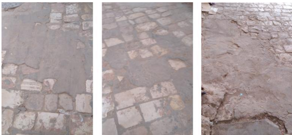
Photo 5.17 : Restauration avec une chape de Béton. Source : Auteurs
