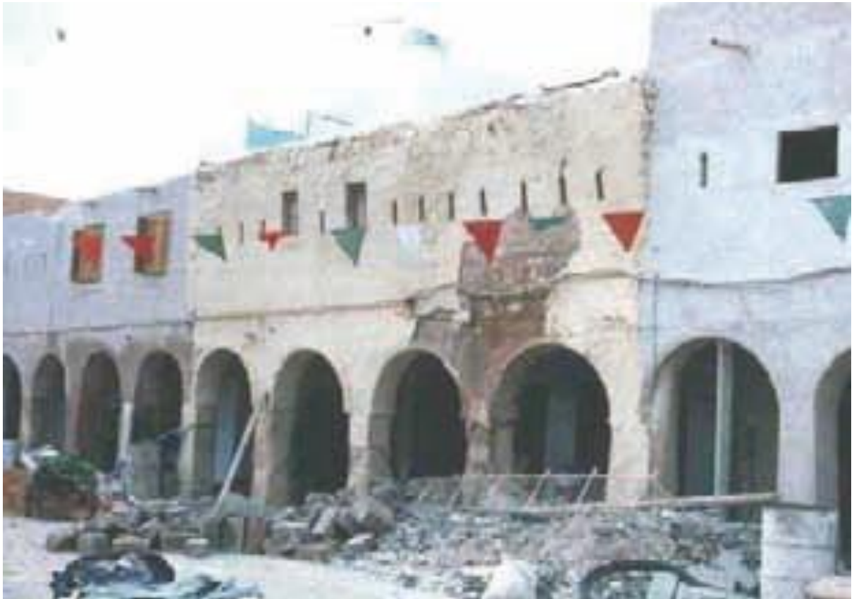
Photo 2.4 : Démarrage des travaux de Décapage les façades. Source : [4]
