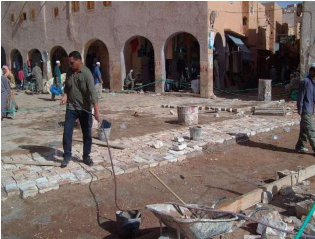
Photo 3.14 : Humidification des pavés. Source : [4]
