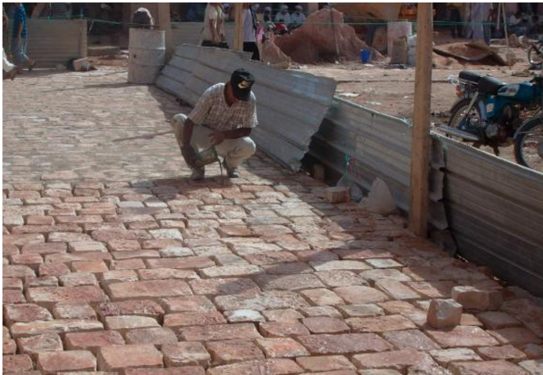
Photo 3.16 : Jointement de pavés en mortier de ciment. Source : [4]
