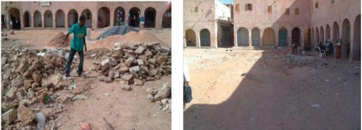
Photo 3.2: Nettoyage et Récupération des anciennes pierres. Source : [4]
