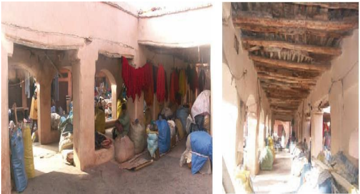
Photo 1.1 : Souk EL- Ghzel, Marrakech avant la réhabilitation. Source : [2]
