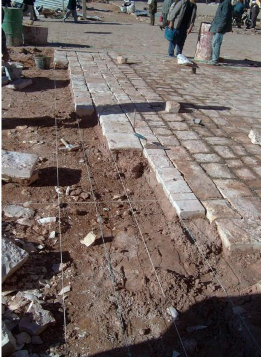
Photo 3.13 : Travaux de pose des pavés. Source : [4]
