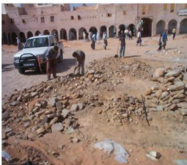
Photo 3.1 : Décapage de l'ancien pavage de la place du marché. Source : [4]
