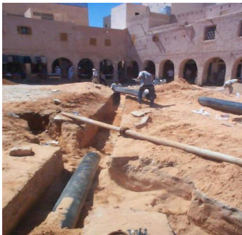
Photo 2.11 : Travaux de pose la conduite principale de réseau d'assainissement Source : [4]
