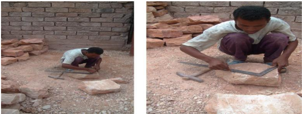
Photo 2.15 : Traçage les pierres. Source : [4]
