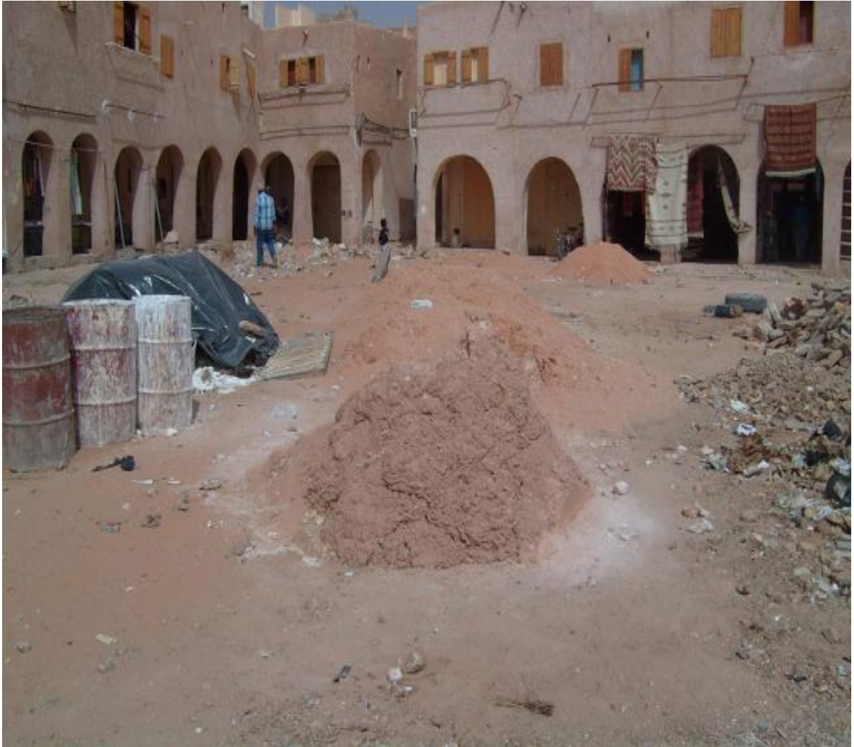
Photo 3.11 : Préparation le mortier de chaux. Source : [4]
