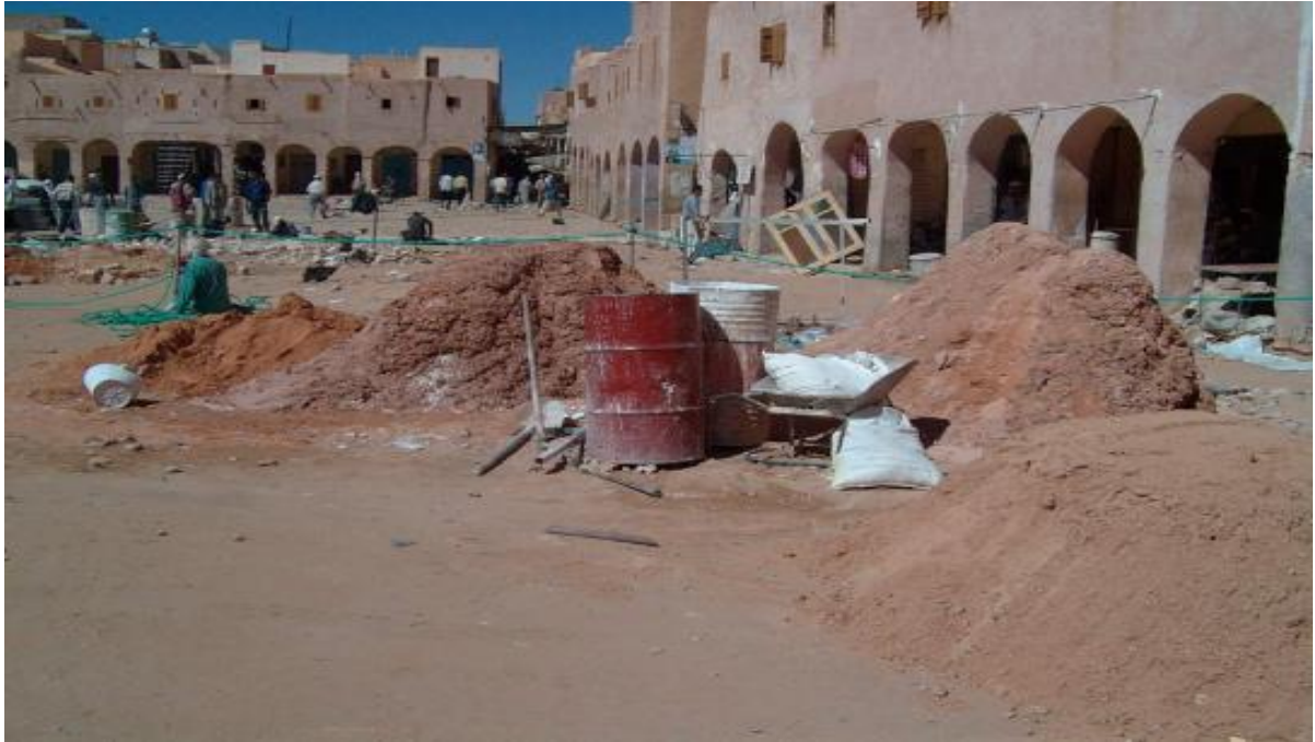
Photo 3.12 : Préparation plusieurs pâtes pour mortier de chaux. Source : [4]
