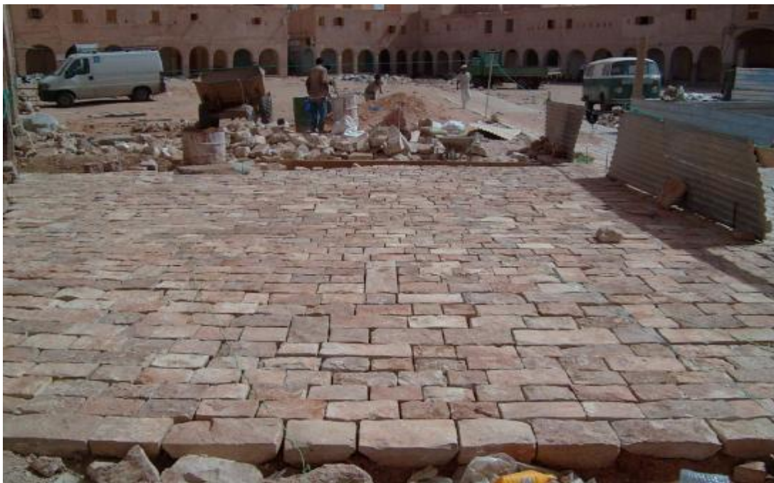
Photo 3.10 : Pavé prêt pour jointement en ciment. Source : [4]
