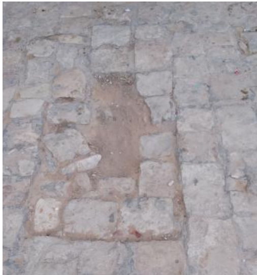
Photo 5.18 : Des pavés de mauvaise qualité. Source : Auteurs
