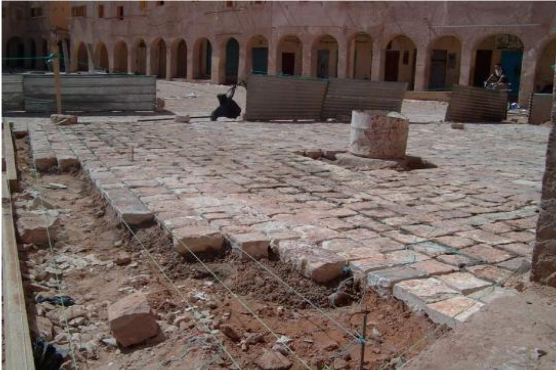
Photo 3.9 : Matérialisation des axes et de niveau et l'alignement de pavés. Source : [4]
