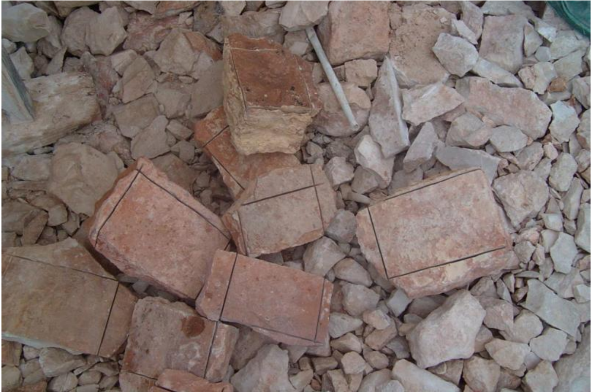
Photo 2.16 : Découpage les pierres. Source : [4]
