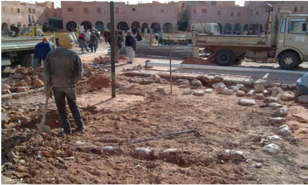
Photo 2.2 : Travaux de la conservation de l'endroit El-Huita. Source : [4]
