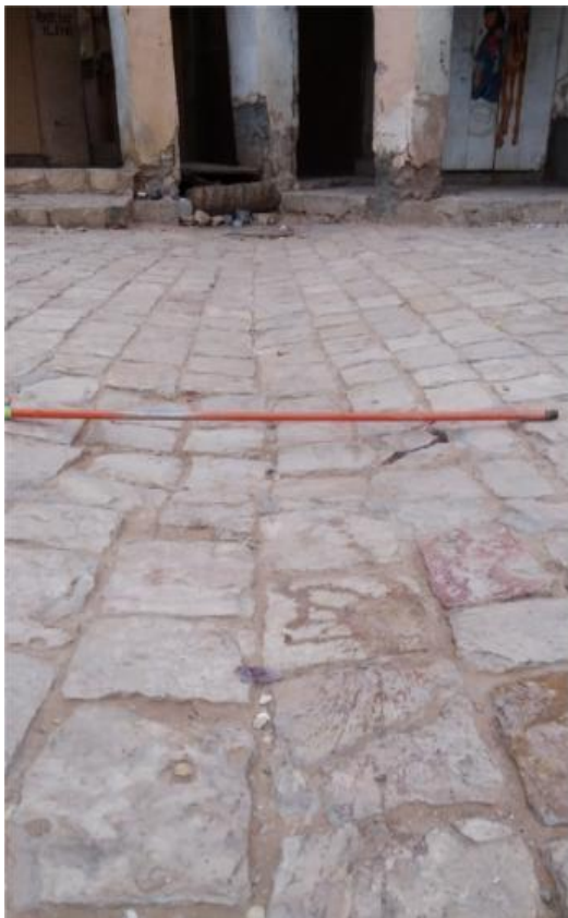
Photo 5.4 : Un mauvais compactage. Source : Auteurs
