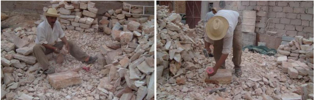
Photo 2.18 : Finalisation des pierres. Source : [4]
