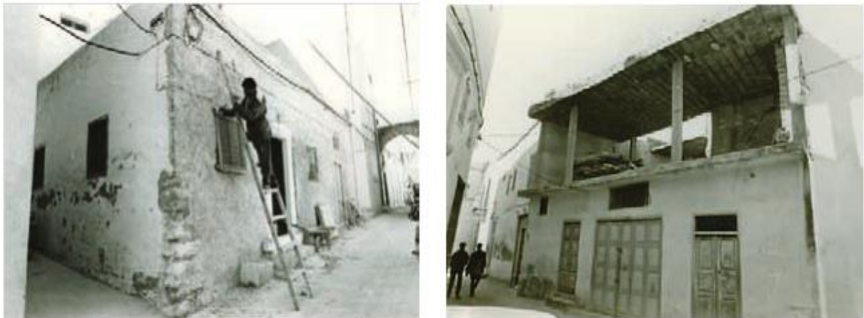
Photo 1.4 : Les corrections architecturales et les consolidations des murs Source : [2]
