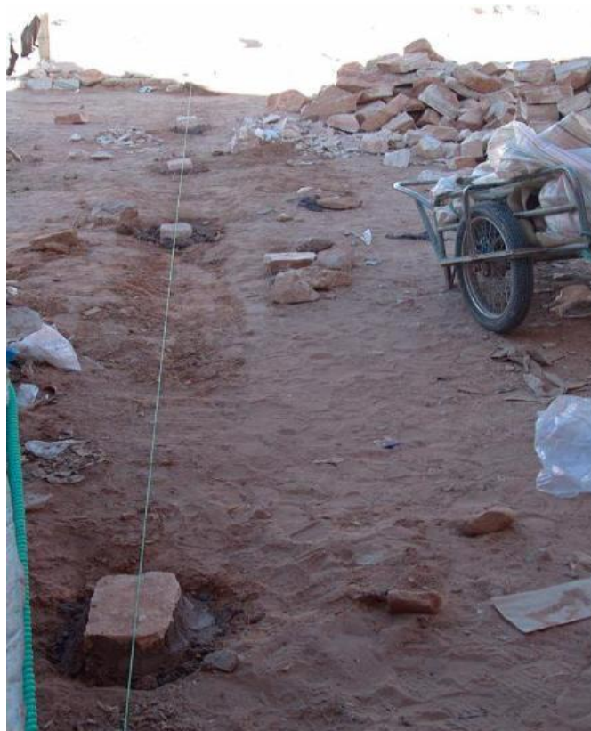
Photo 3.7 : Matérialisation le niveau et l'alignement de pavés. Source : [4]
