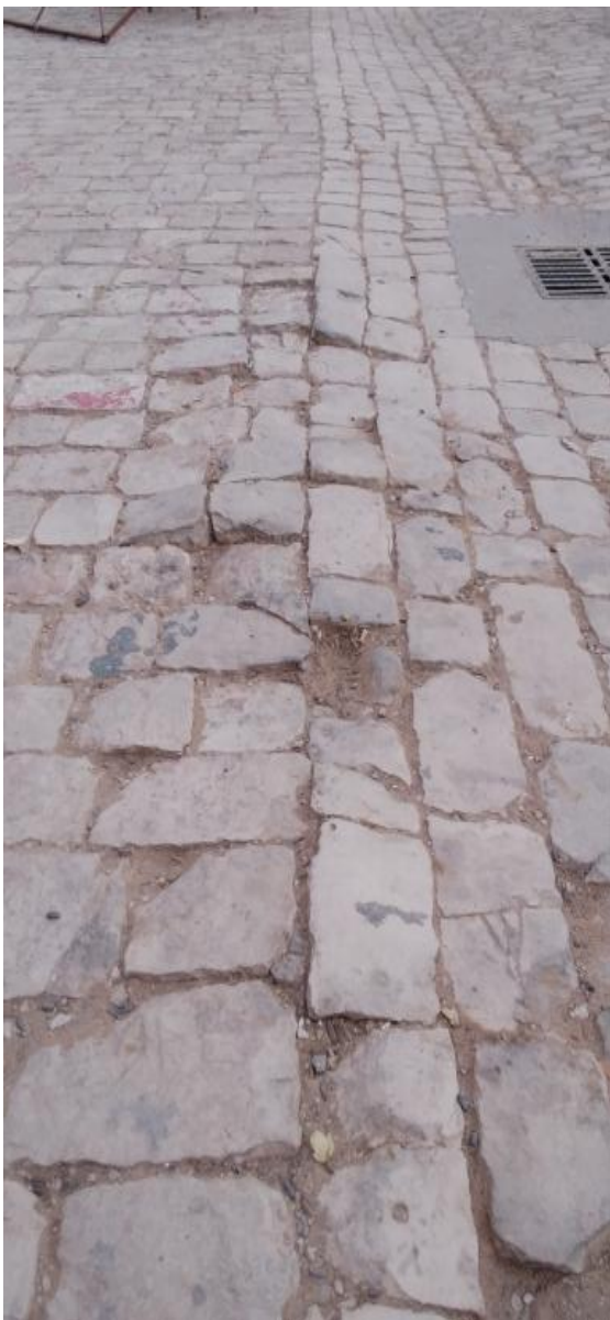
Photo 5.6 : Défaut d'uni longitudinal. Source : Auteurs
