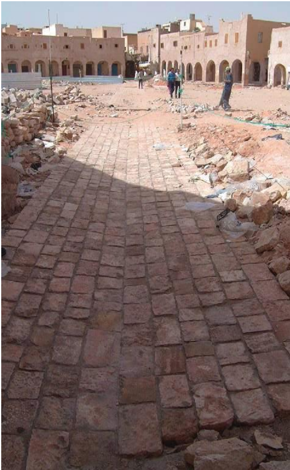
Photo 3.5 : Travaux de pavés de la rigole. Source : [4]
