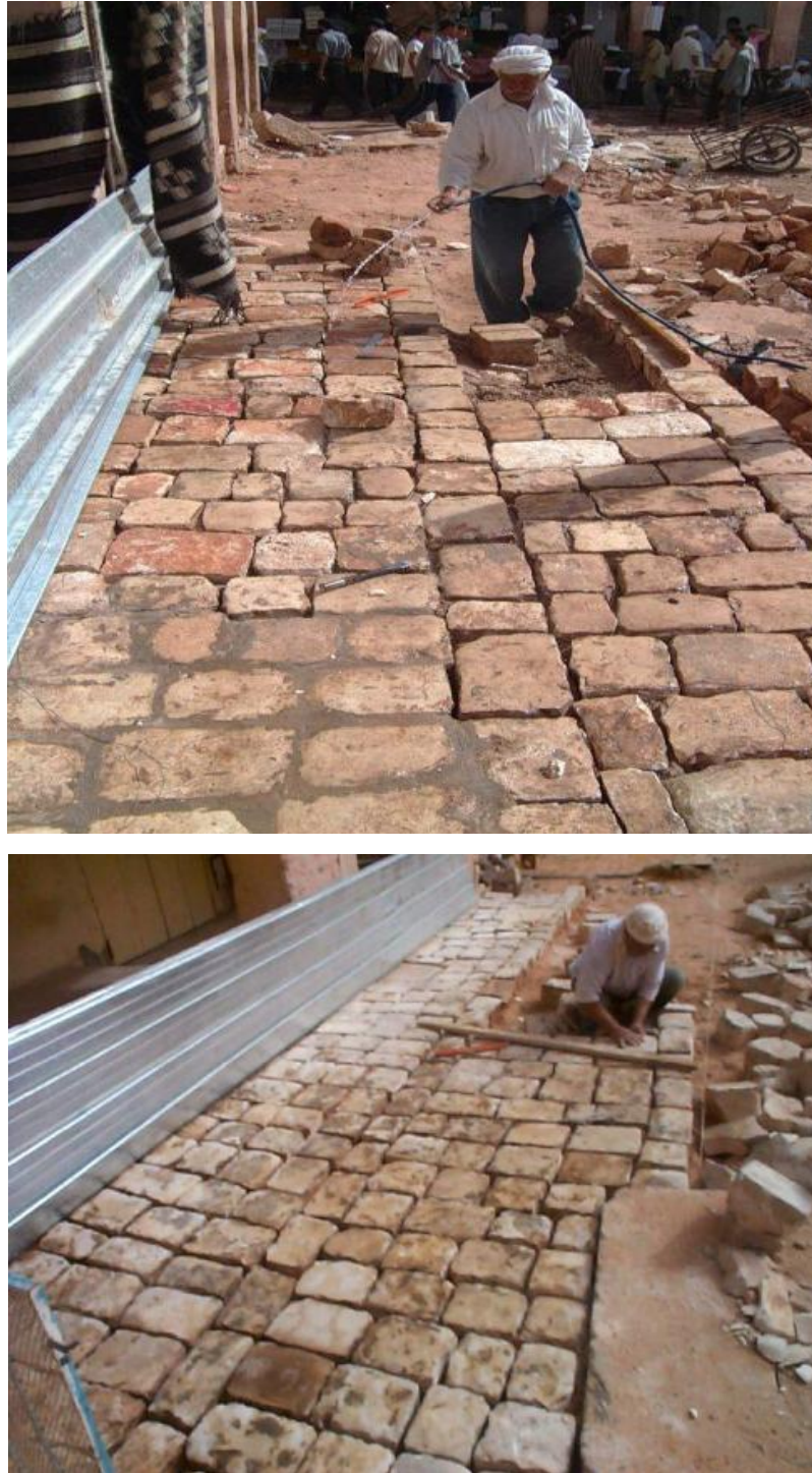
Photo 3.15 : Humidifier préalablement le pavé avec de l'eau pure. Source : [4]
