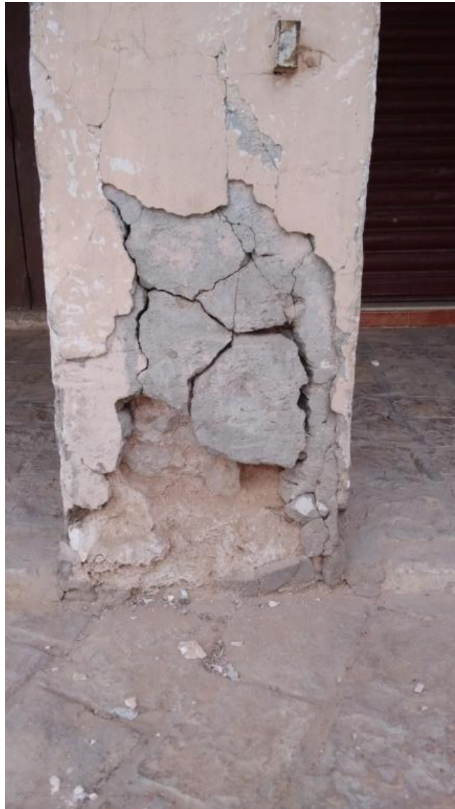
Photo 5.21 :Des matériaux de construction hétérogène. Source : Auteurs
