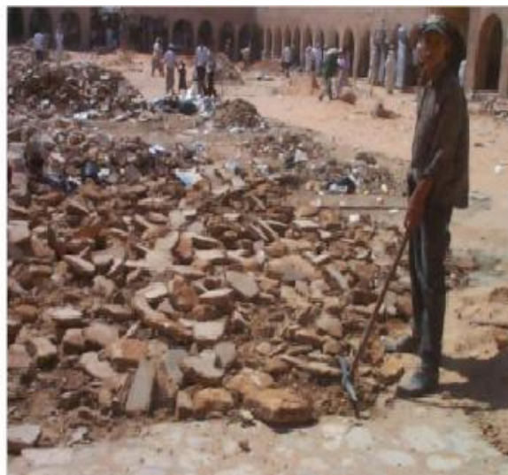
Photo 3.1 : Décapage de l'ancien pavage de la place du marché. Source : [4]
