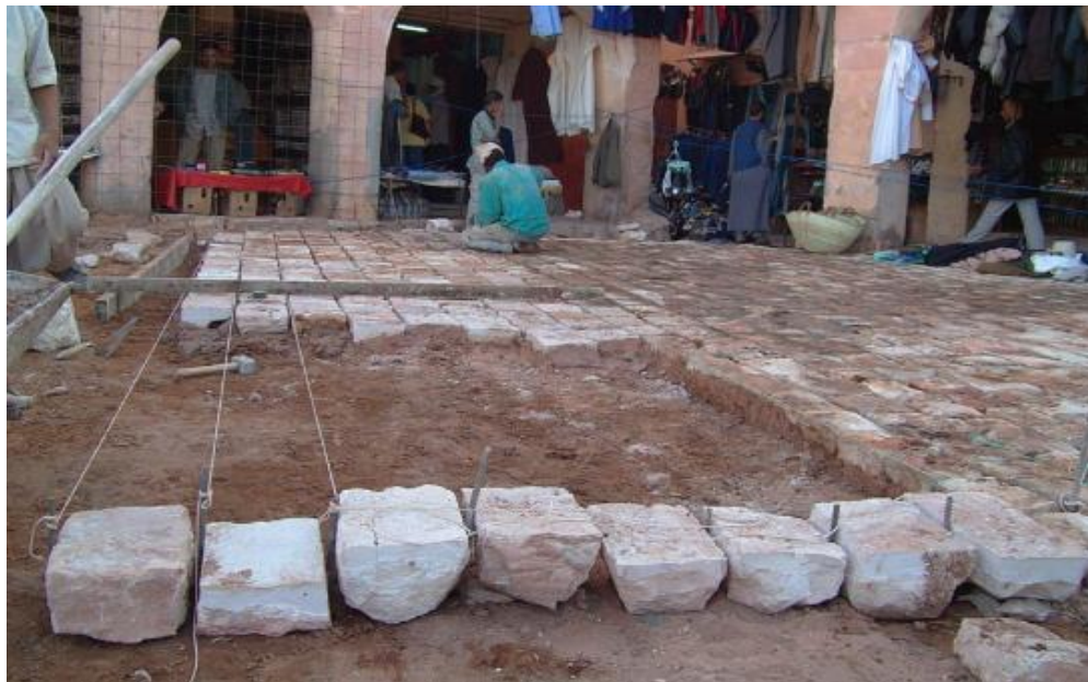
Photo 3.8 : Matérialisation les axes et l'alignement de pavés. Source : [4]
