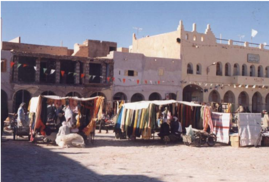
Photo 2.7 : la façade sud-ouest de la place marchée. Source : [4]
