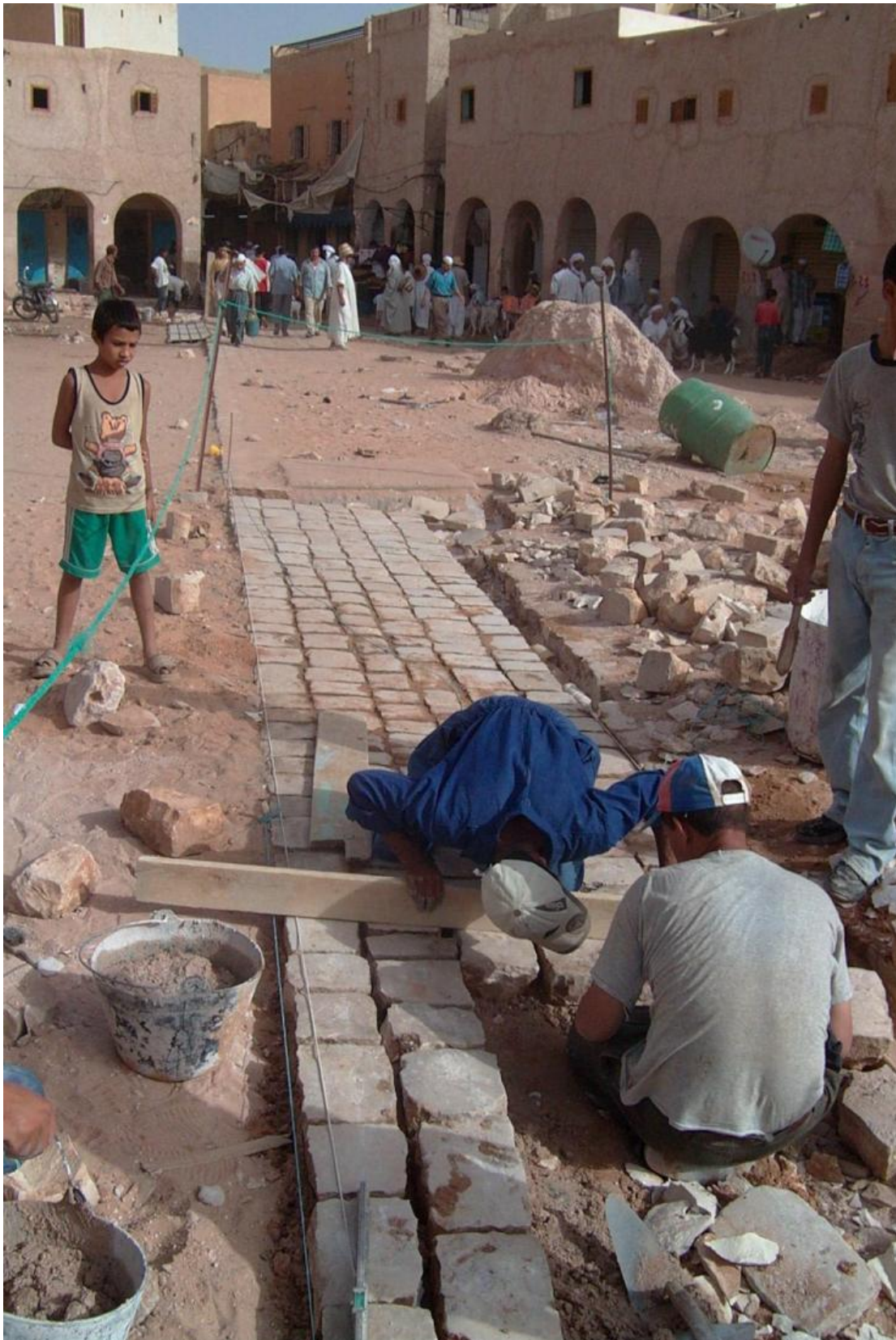
Photo 3.4 : Travaux de pavés de la rigole. Source : [4]
