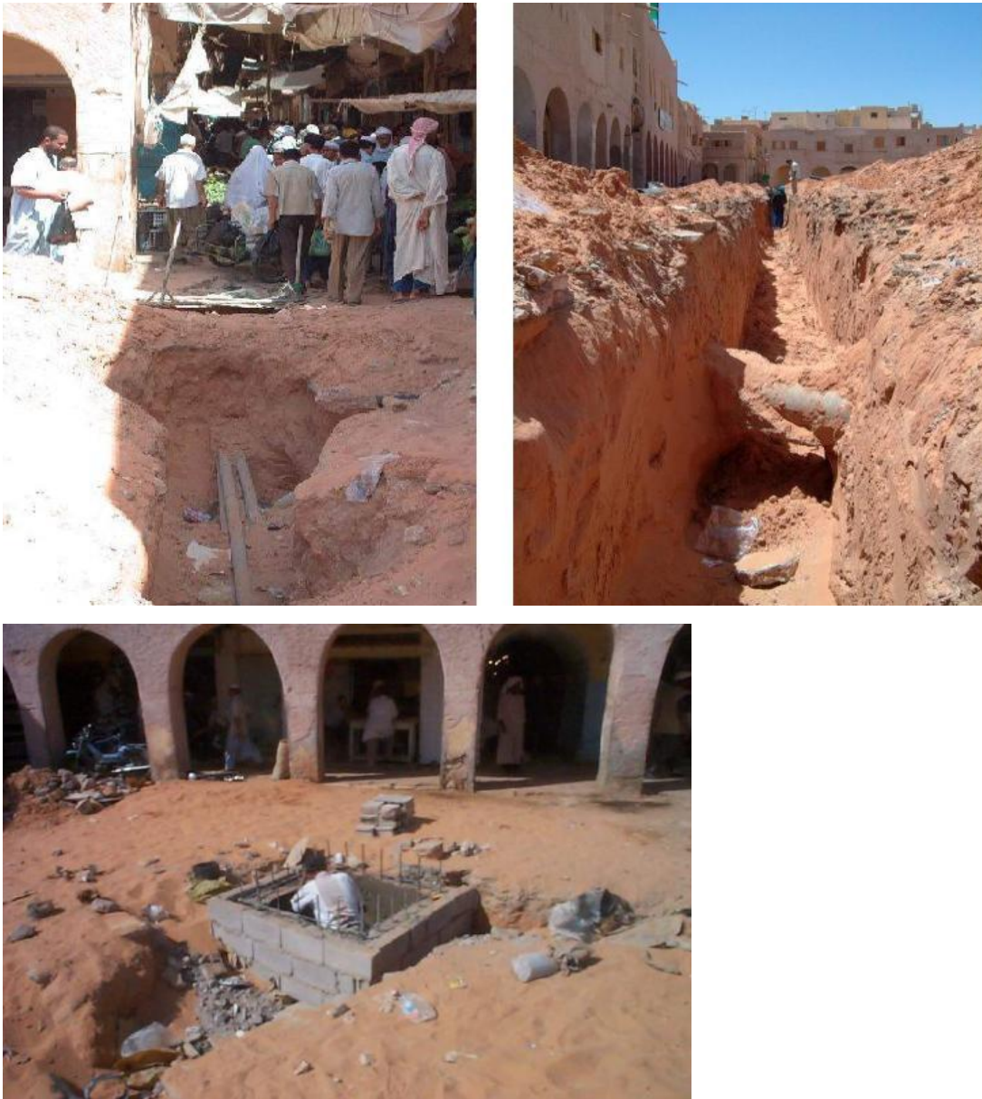
Photo 2.9 : Travaux de réseau d'assainissement. Source : [4]
