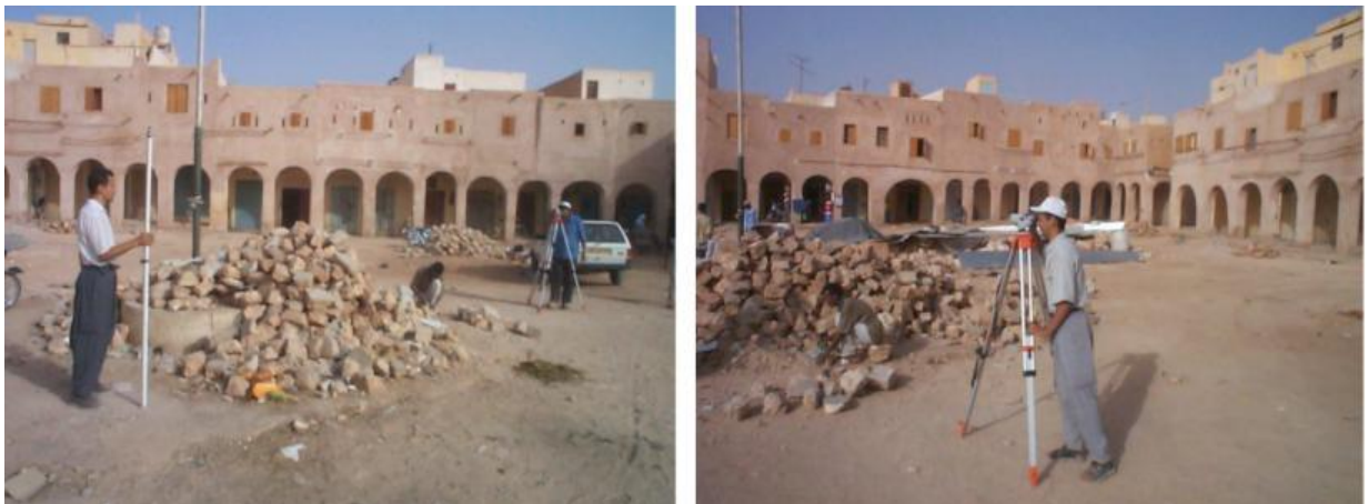
Photo 3.3 : Travaux de nivellement topographique et piquetage. Source : [4]
