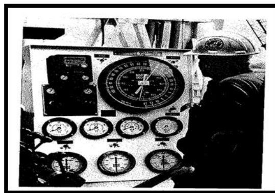
Figure 3-04 : Chambre de commande.
