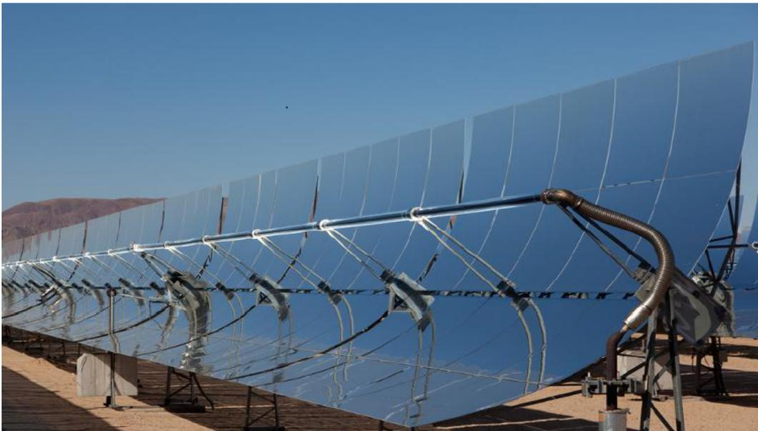
FIGURE 4.5 – Concentrateur cylindro-parabolique
