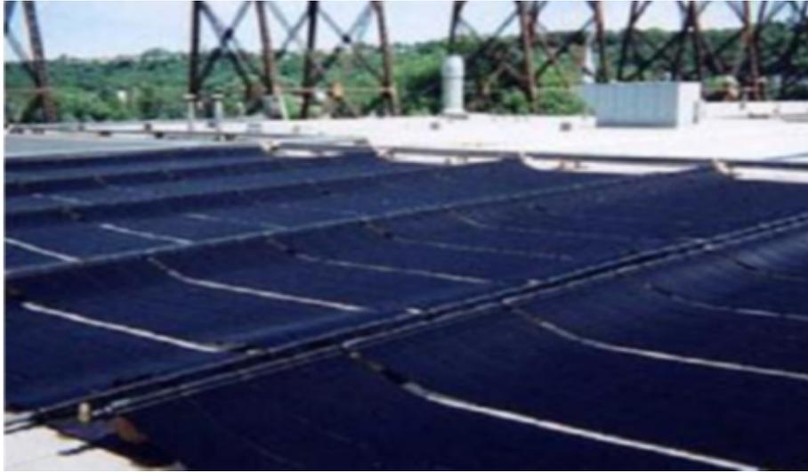
FIGURE 4.1 – Capteur solaire sans vitrage
