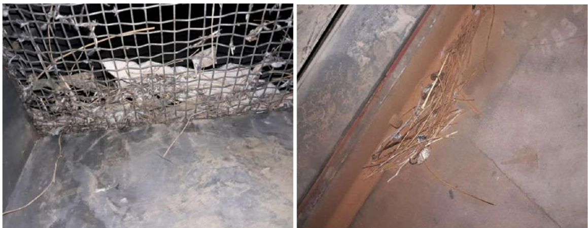
Figure IV.1 : Plumes, herbes et déchets dans le Couloir d'écoulement d'air
