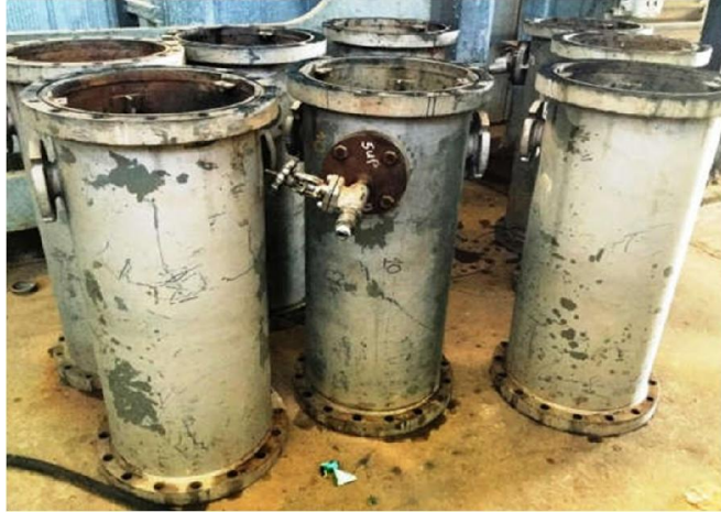
Figure IV.7 : Chambres de combustion
